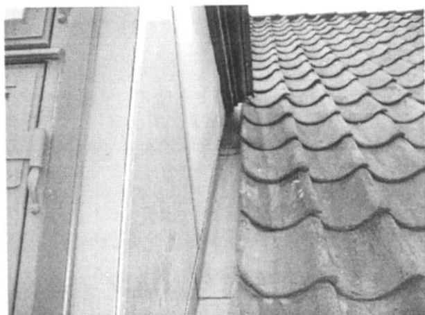
Afløbsrende ned langs kvistflunke
