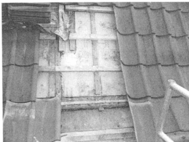
Oplukning af tagbelægning mod gårdsiden. Der ses ingen fugtskjolder på undertaget.
