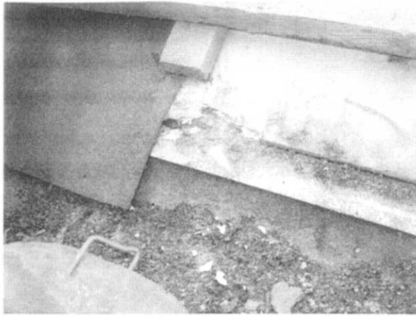
Mindre skade på undertagsplade.
