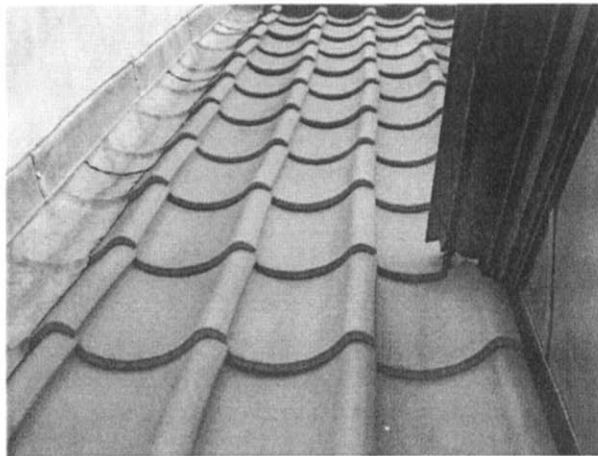
Inddækning med bly og zinkløskant langs brandkam på gårdsiden.
