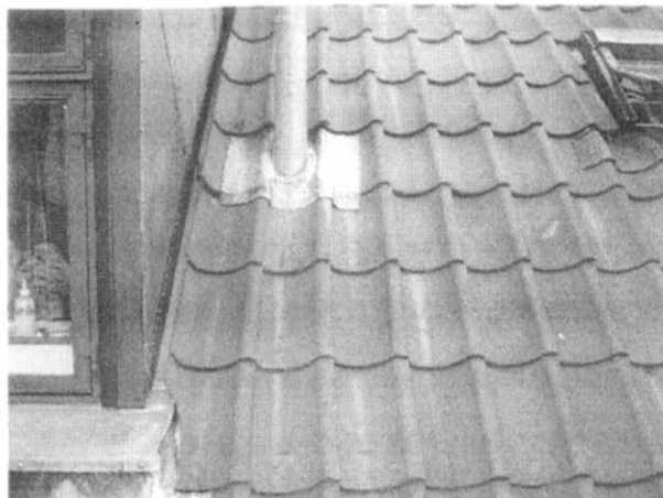
Afløbsrende ned langs kvistside, gårdsiden
