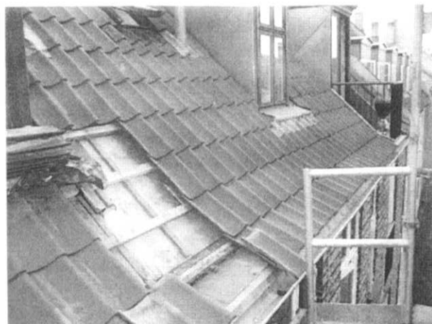
Oplukning på tagflade omkring kvist på gårdsiden.
