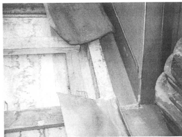
Afløbsrende ned langs kvistside efter demontering af teglsten.
